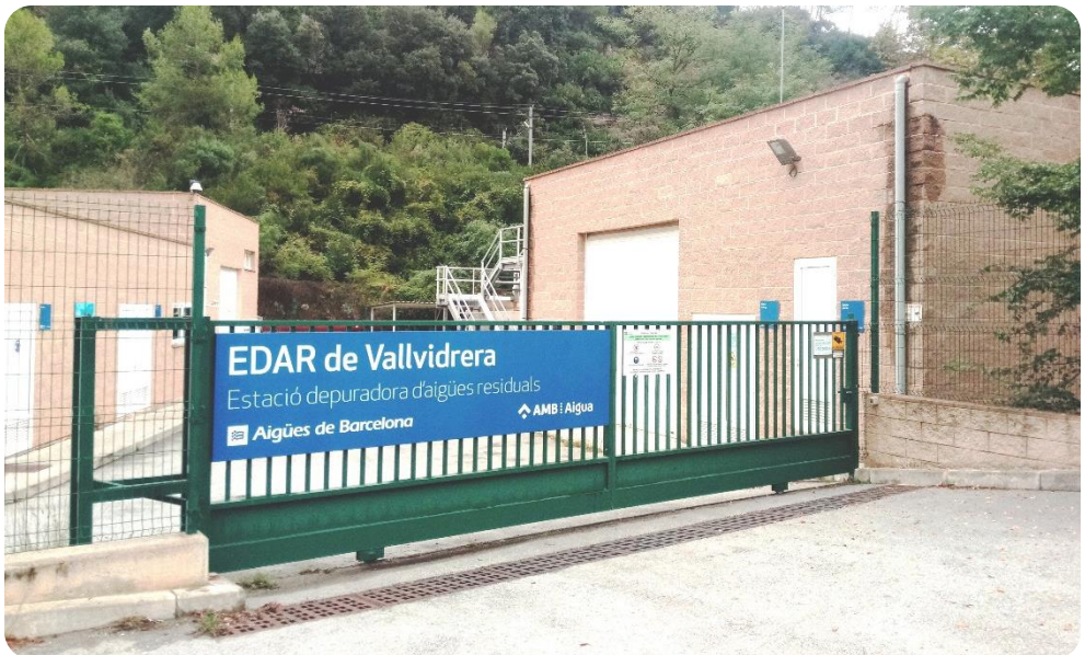
Figura 3. Porta d'entrada a la EDAR de Vallvidrera.
