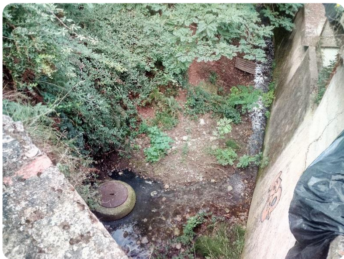
Figura 4. Un dels impactes més greus que pateixen algunes rieres de La Floresta són les fuites d'aigua residual des de la xarxa de clavegueram com passa a la riera de Can Bova.
