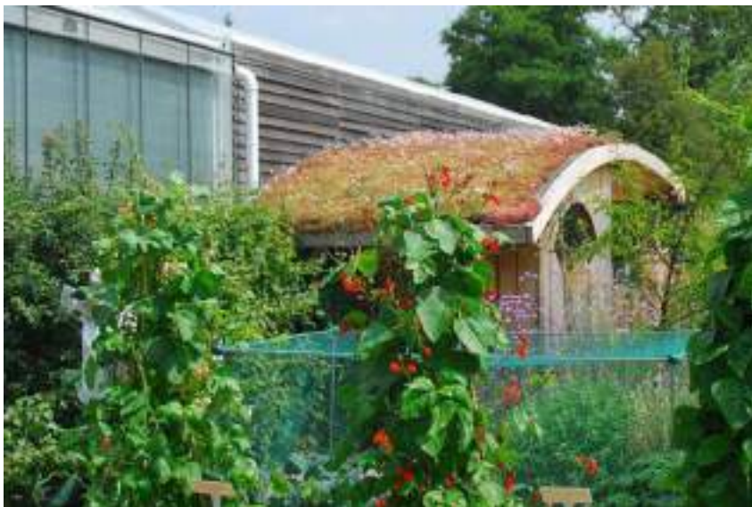
Teulada vegetal que també serveix per recollir l'aigua.
